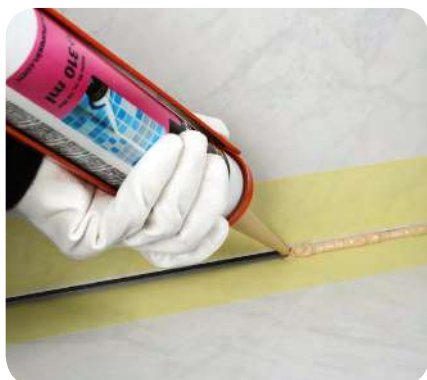
16. Do škár dôkladne natlačíme Murexin Silikónové tesnenie škár SIL 60.
