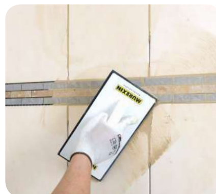
12. Po dostatočnom vytvrdnutí lepiacej malty obklad vyškárujeme. Škárovaciu maltu Murexin FM 60 Premium nanášame vždy pod 45° uhlom na škáry.
