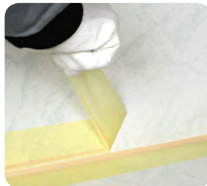
18. Ihneď po zahladení silikónového tesnenia odstránime maskovaciau pásku.
