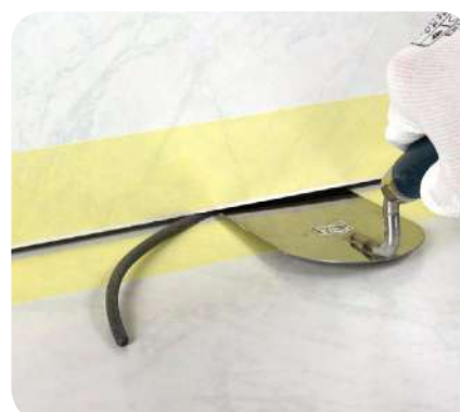
15. Spoj stena-stena a stena-podlaha oblepíme maskovaciau páskou a natlačíme do nich Murexin škárovací povrazec.
