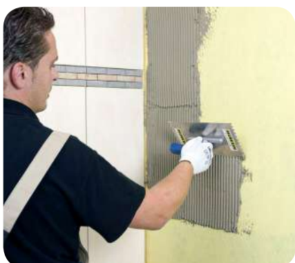
10. Na zaschnutú hydroizoláciu nanesieme zubovým hladidlom Murexin Pružnú lepiacu šedú KGF 65.
