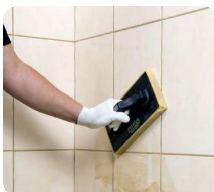
14. Po zaschnutí škárovacej malty obklad dôkladne poumývame čistou vodou a prípadné zbytky škárovacej malty odstránime Murexin Kyselinový čistič Colo SR 30.
