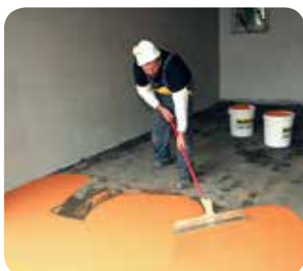
10. Ozubenou stierkou živicu rovnomerne roznesieme po ploche a postupne dolievame ďalšiu hmotu.
