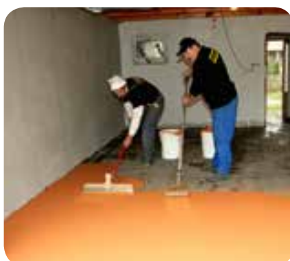
11. Ihneď po roznesení hmoty na podklad ju odzdušňujeme odzdušňovacím valcom. Odstránia sa tak vzduchové bubliny, ktoré vznikli pri miešaní živice.
